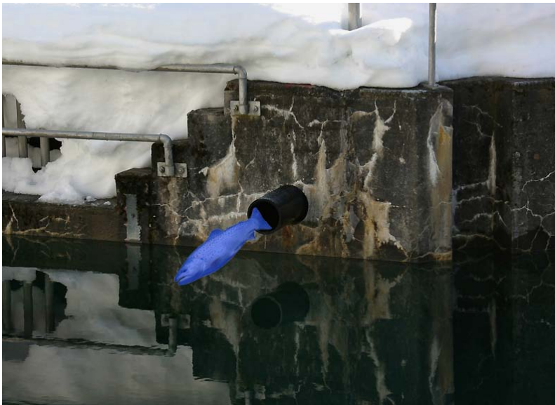
Abb. 10: Austritt der Fischrutsche in das Oberwasser
