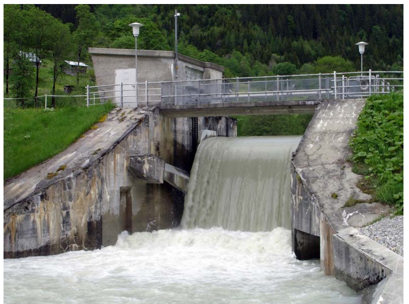
Abb. 2: Das Querbauwerk vor der Realisierung
