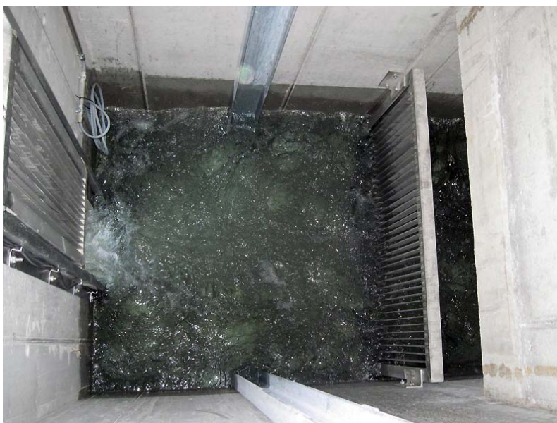
Abb. 7: Der Einstieg in den Fischlift
