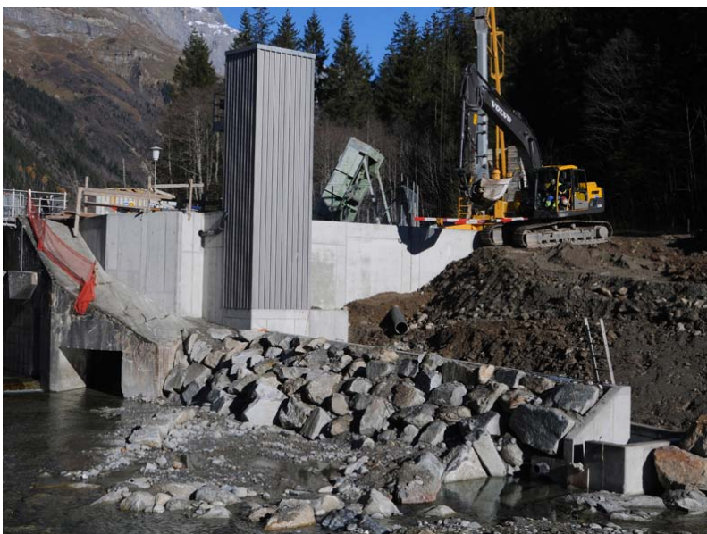
Abb. 4: Fischlift im Bau
