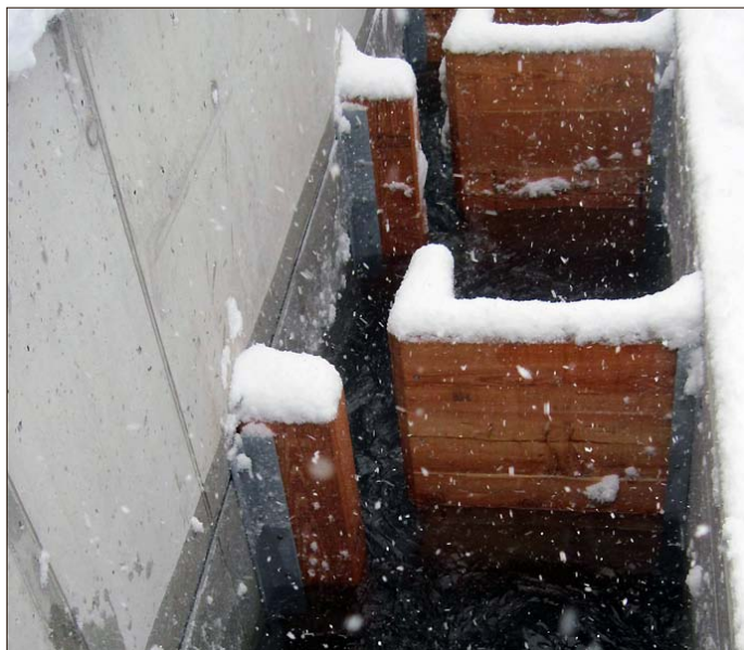
Abb. 5: Anordnung eines Beckens im Fischpass
