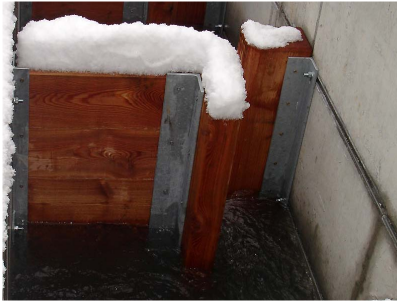
Abb. 6: Detailsicht eines Durchlassschlitzes
